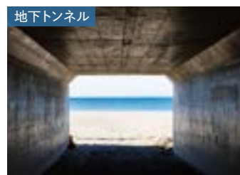
地下トンネル
