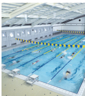
床が上下可動式の屋内温水プール。
